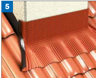
(Bild 5) Eckvariante 1: Mit einem Umschlag von ca. 2 cm das DELTA®-Anschlussband auf beiden Seiten umlegen, so dass die Klebefläche sichtbar ist. Danach das DELTA®-Anschlussband an den Deckwerkstoff anformen.
