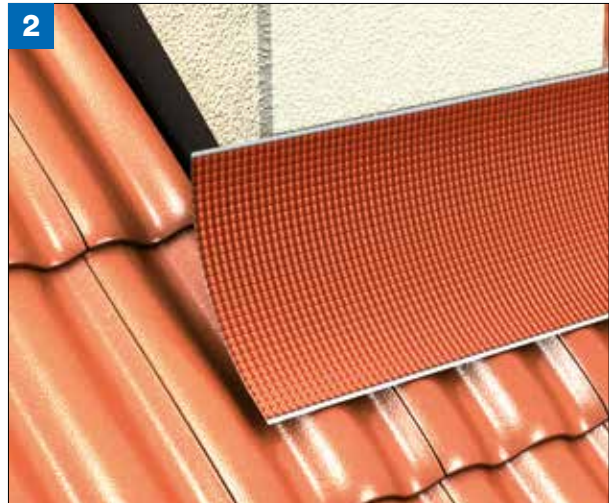
(Bild 2) Eckvariante 1: DELTA®-TOP FLEXX auf beiden Seiten mit ca. 3–5 cm Überstand ablängen.
